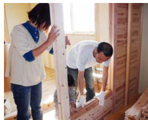
△家族3人で間仕切壁を作ることができる 写真：川辺の住宅（2009年）
